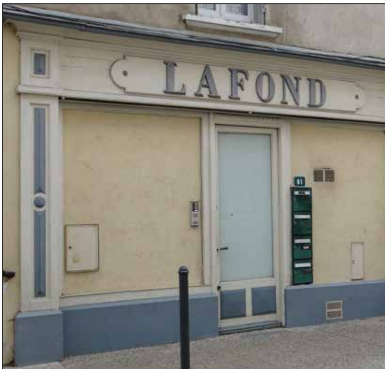
BEAUREPAIRE - Exemple de transformation d'un rez-de-chaussée commercial en habitation
