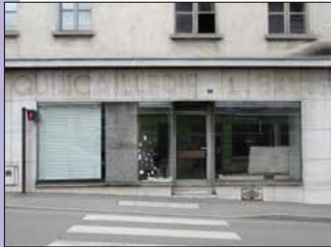
BEUREPAIRE - Commerce vacant et dégradé sur l'Avenue Victor Hugo
