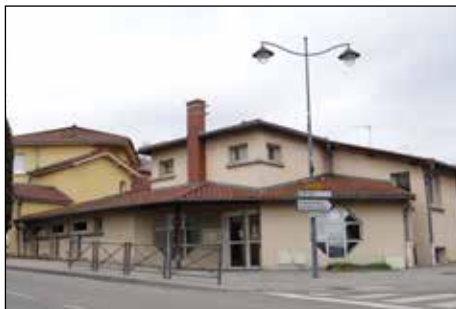
BEAUREPAIRE - Maison médicale actuelle, qui ne parvient pas à répondre aux besoins
