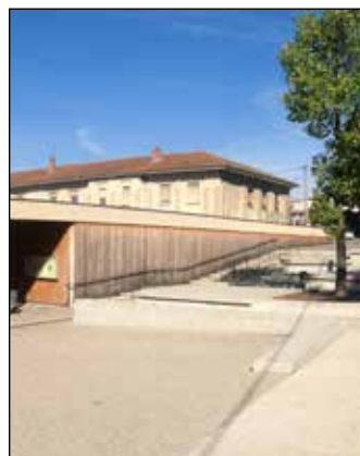
ROUSSILLON - Aménagement du parvis de l'école de manière apaisée, sécurisée et accessible
