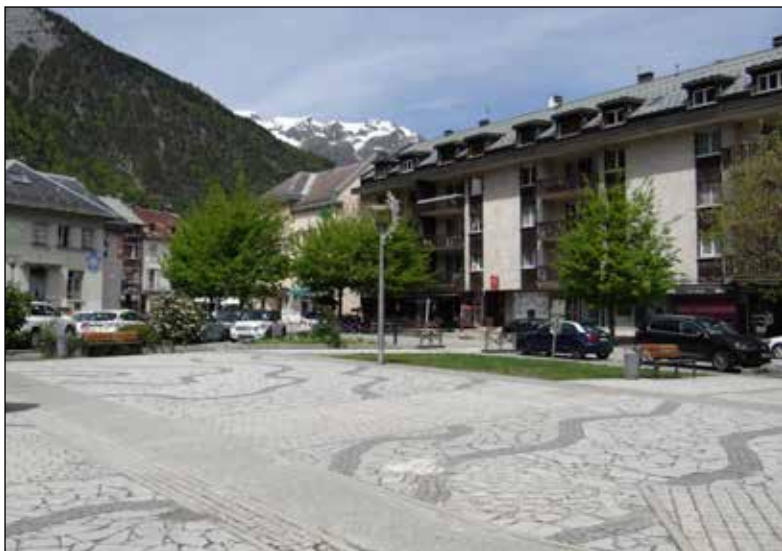
LE BOURG D'ISANS - Exemple de requalification et d'aménagement d'espace public
