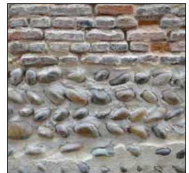
BEAUFORT - Rénovation d'une façade avec la mise en valeur des matériaux de construction traditionnels
