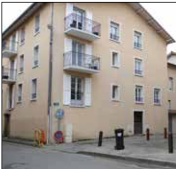
BEAUREPAIRE - Réhabilitation d'un bâtiment ancien, et division en logements collectifs
